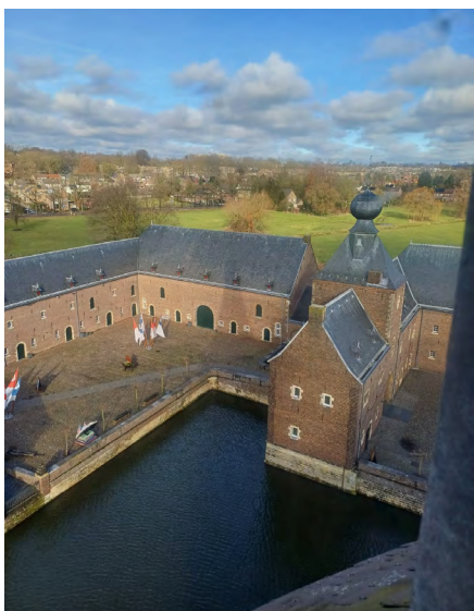
Kasteel Hoensbroek, pohled z věže © z archivu Ivany Findurové
